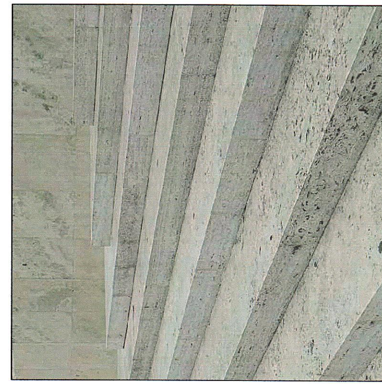
COPERTINE PARAPETTI E GRADINI IN TRAVERTINO
