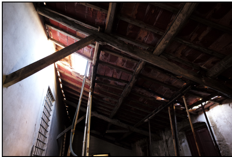
Foto n°2 (Strutture di copertura puntellate)
