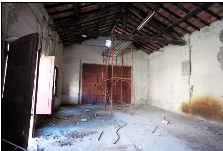
Foto n°6 (Puntellature delle strutture lignee)
