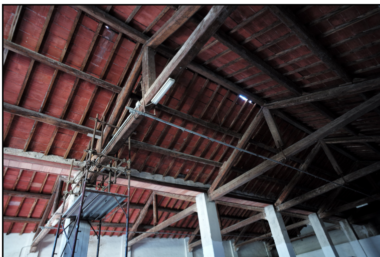
Foto n°5 (Sostegni e puntelli)
