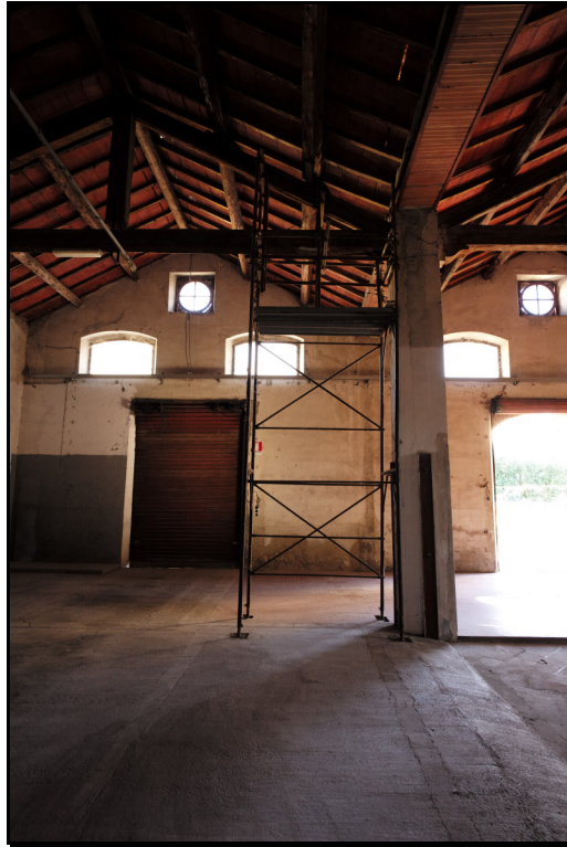
Foto n°1 (struttura principale di copertura puntellata)
