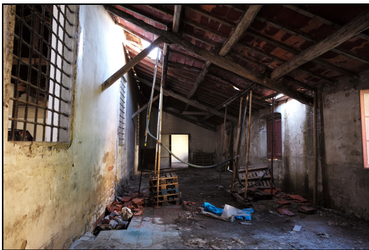
Foto n°3 (Strutture di copertura puntellate)
