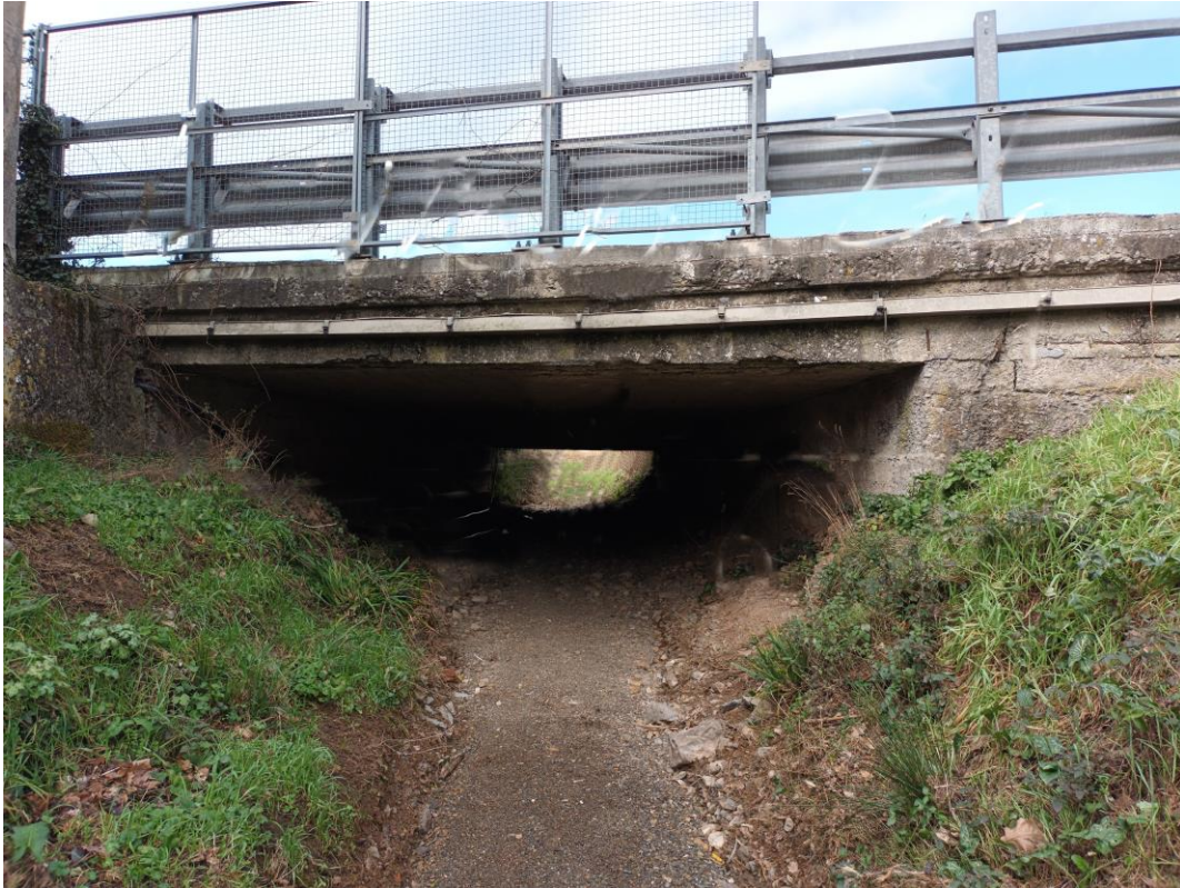
Figura 51 – Rio Bechini -attraversamento sull’A11 visto da monte
