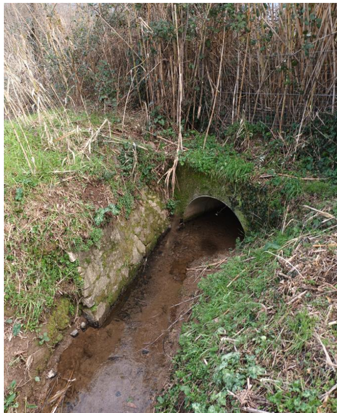
Figura 52 – Rio Bechini destro-uscita del tratto tombato a valle dell’A11
