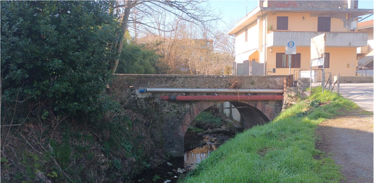
Figura 39 – Rio Gerbi attraverso su Via Pozzarello visto da monte
