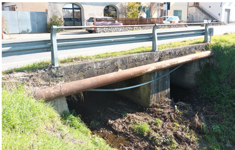
Figura 16 – Uscita del tratto tombato "Fosso 3" a valle della SR436
