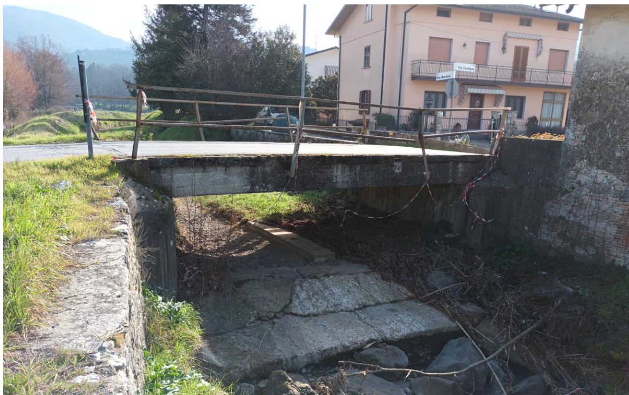
Figura 50 – Rio Bechini attraversamento su Via Tre Fontane visto da valle
