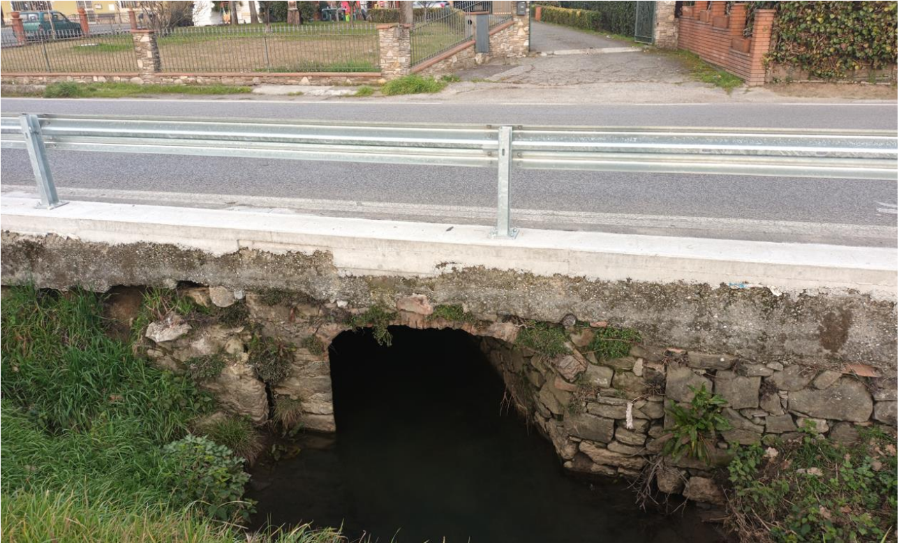
Figura 8 – Sistema Uggia-Pazzera – Sbocco del tratto tombato in prossimità della SR 436
