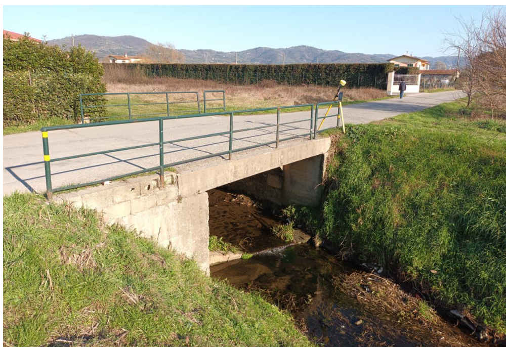
Figura 25 - Rio Pietraia attraversamento su via Bracona
