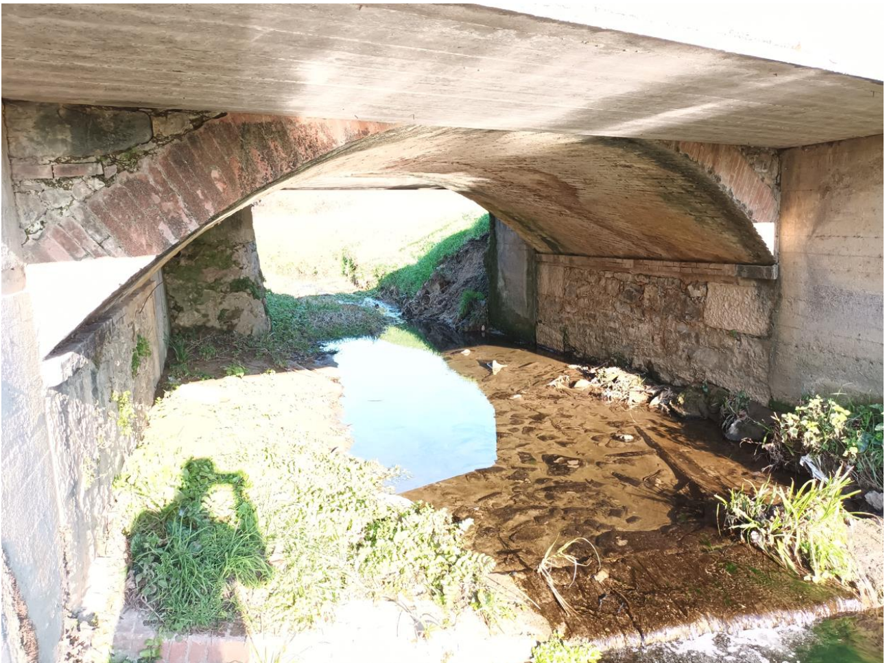
Figura 5 - Rilievo sul Rio Pietraia, attraversamento carrabile su Via Bracona
