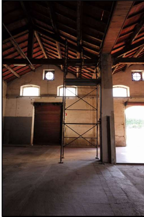
Foto n°1 (struttura principale di copertura puntellata)
