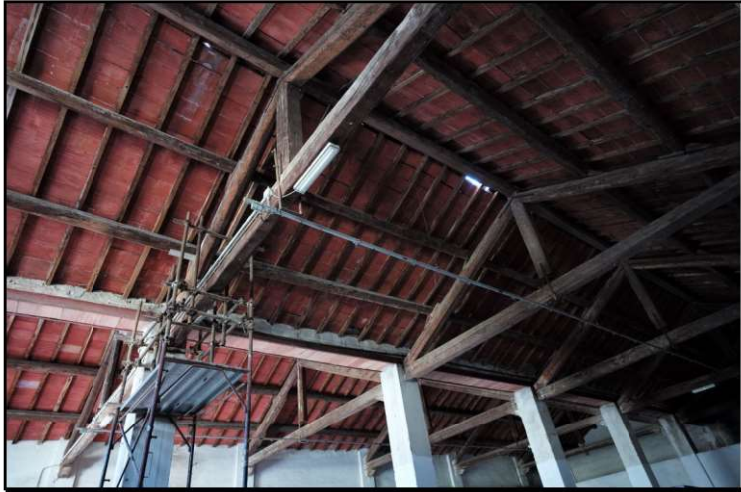
Foto n°5 (Sostegni e puntelli)
