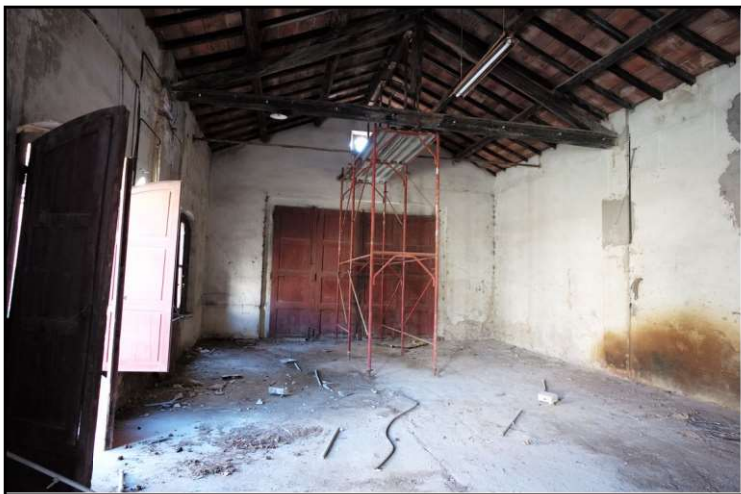
Foto n°6 (Puntellature delle strutture lignee)
