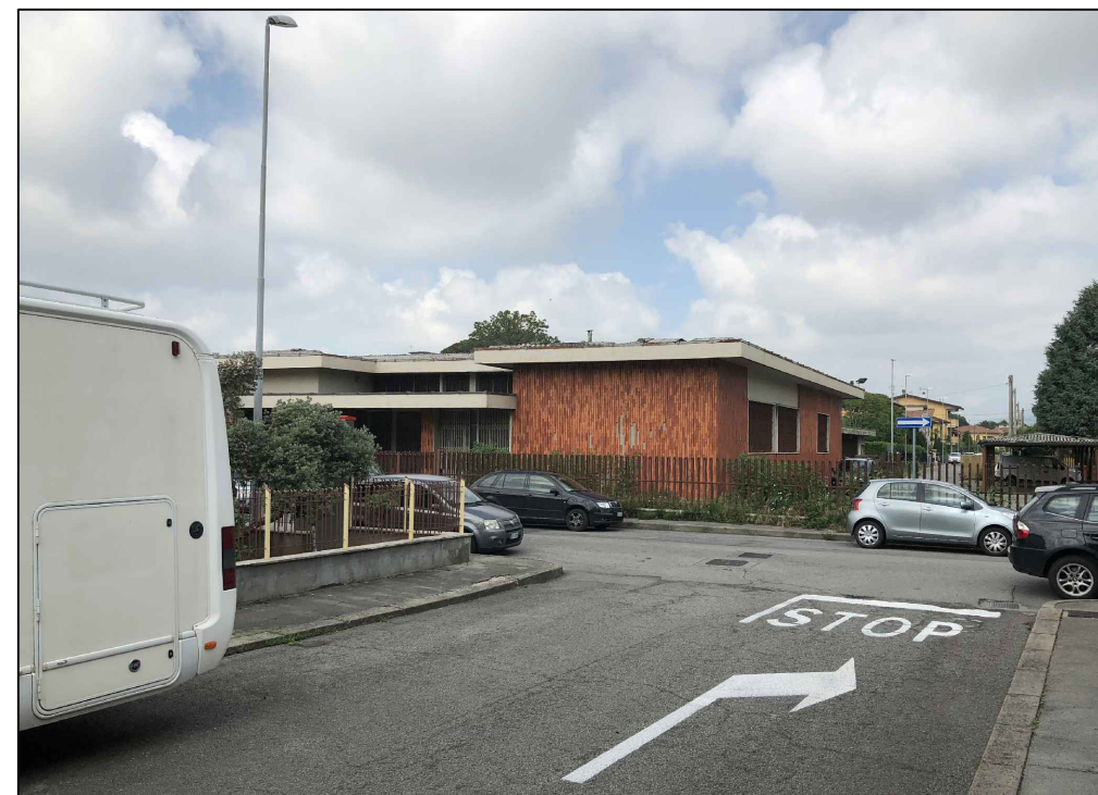
FOTO PRIMA DELL'INTERVENTO
